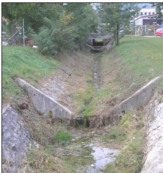
Slika 29: Stabilizacija struge s prečnim pragom višine 50 cm in urejenim podslapjem in tolmunom (Prebil, 2009)
