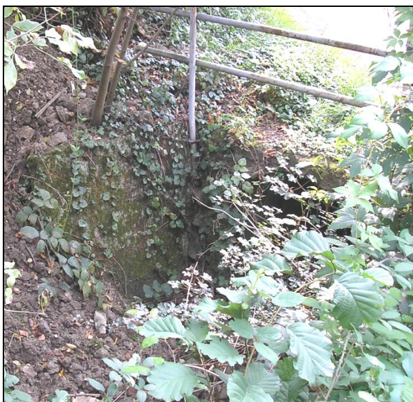
Slika 36: Pogled na propust v Pavšičevem naselju (Prebil, 2009)
