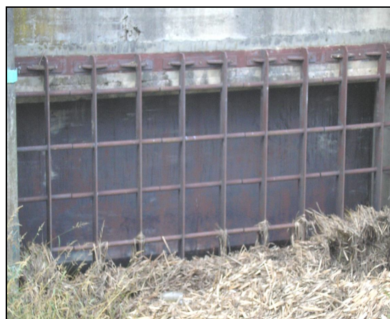
Slika 70: Zapornični objekt (Prebil, 2009)
