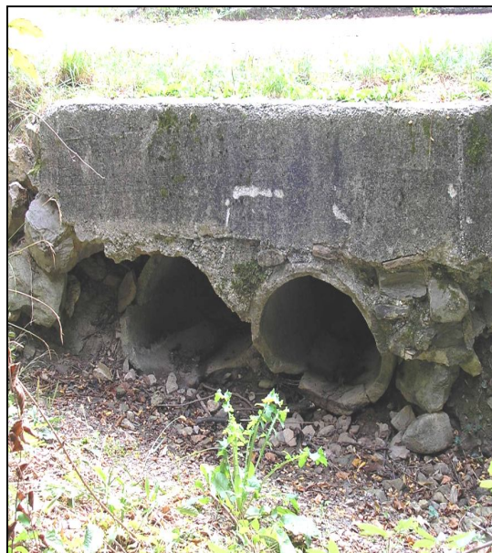
Slika 38: Iztočni del propusta 2x \Phi 70 cm (Prebil, 2009)
