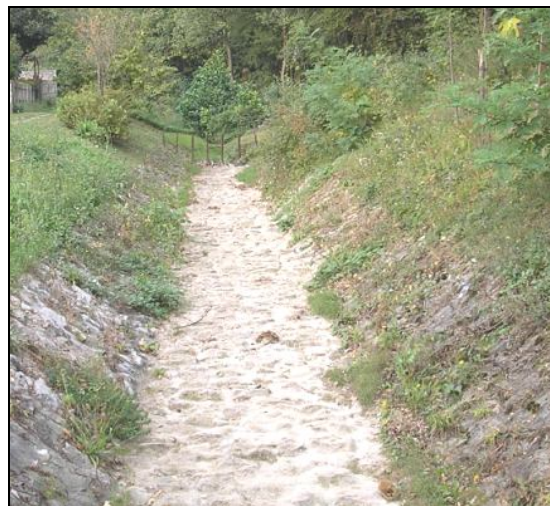
Slika 51: Na zaključku regulacije grobe grablje (Prebil, 2009)
