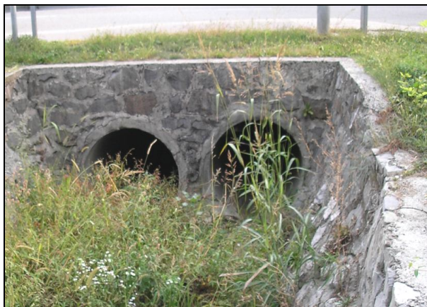
Slika 47: Dvocevni propust pod staro vpadnico v mesto (Prebil, 2009)
