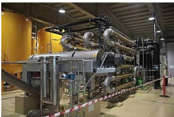
Slika 4: Čistilna naprava za izcedne vode na deponiji Barje (vir: http://www.ljubljana.si/si/mol/dogodki/68573/detail.html , 13.8.2011)
