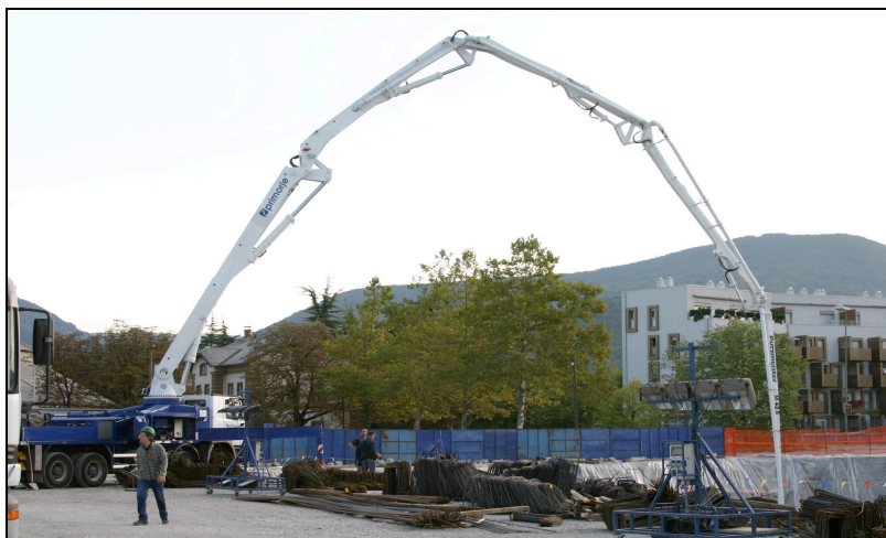
Slika 11: Betonska črpalka – Putzmeister, 42 m
