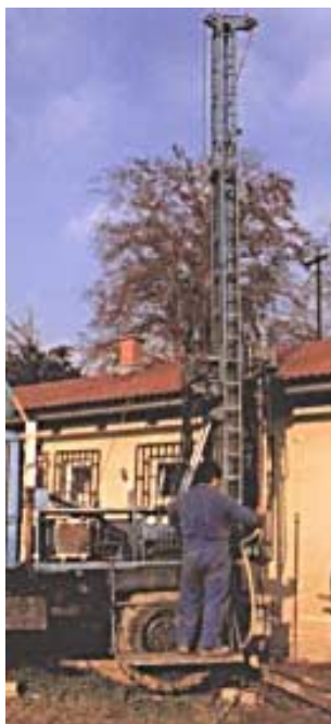
Slika 8: Vrtanje vrtine (Geosonda d.o.o., 2005)
