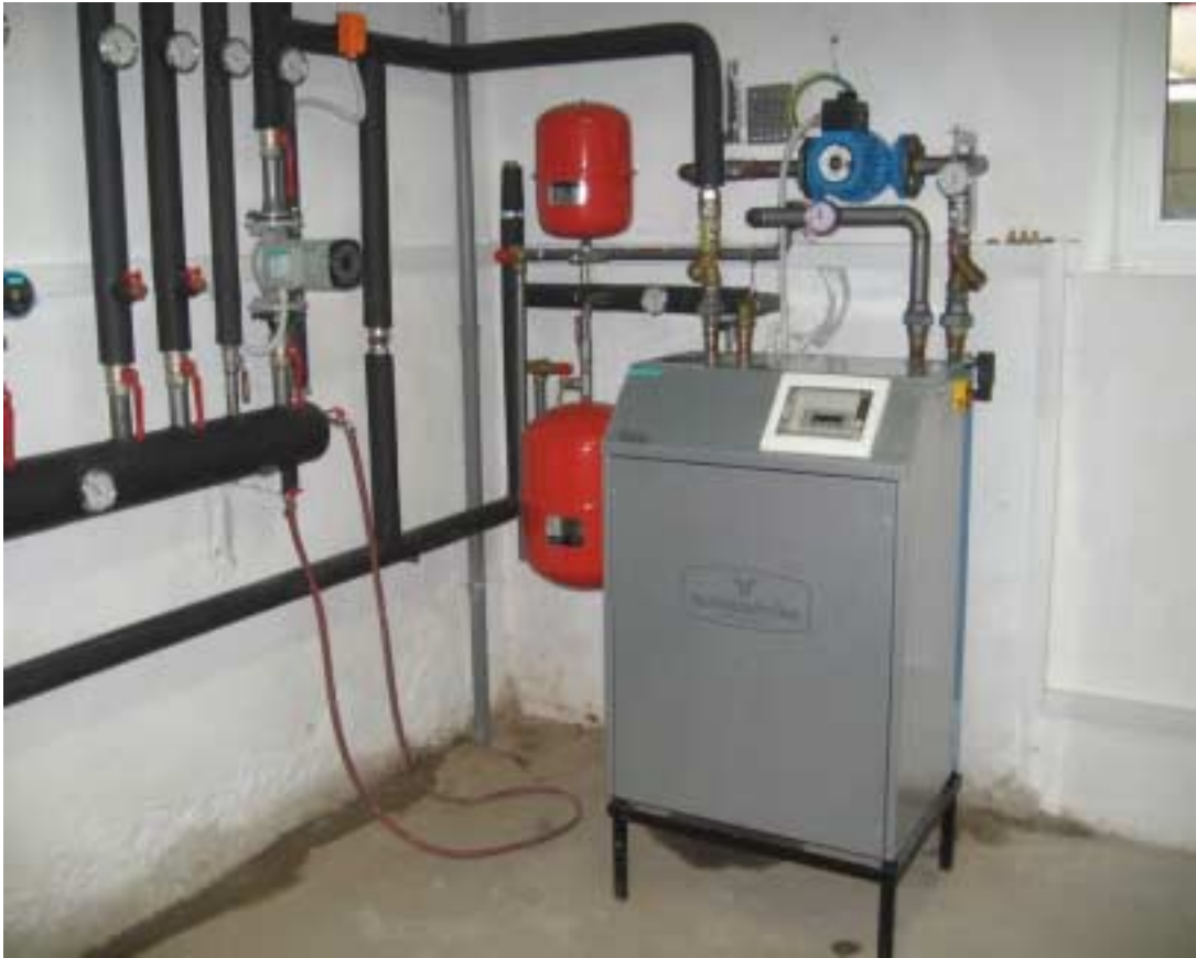
Slika 20: Toplotna črpalka v stanovanjski hiši (fotografirano 30.1.2006)
