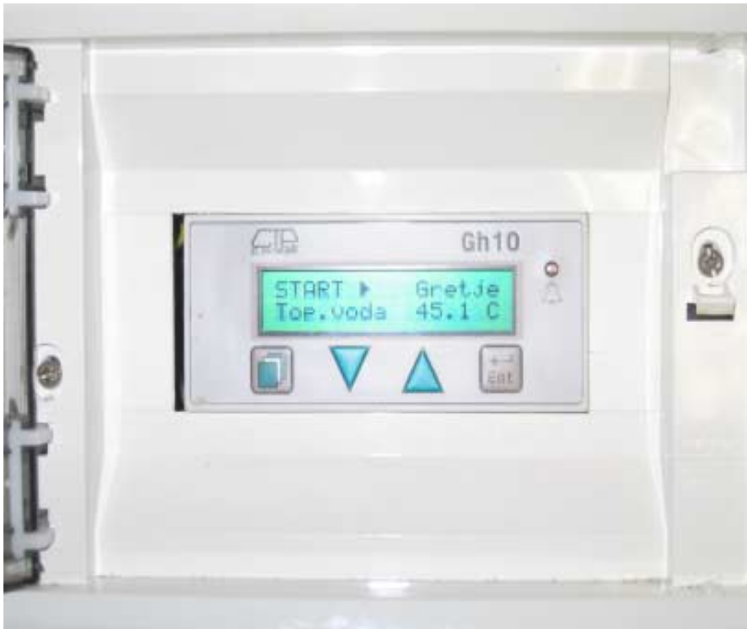
Slika 21: Zaslona na toplotni črpalki (fotografirano 30.1.2006)
