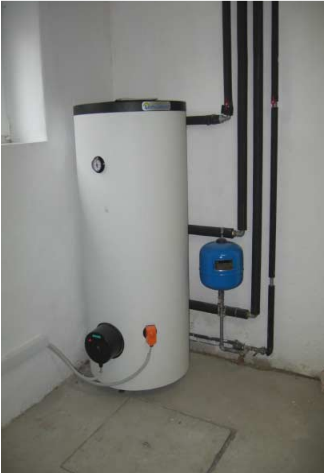
Slika 22: Zbiralnik vode, povezan s toplotno črpalko (fotografirano 30.1.2006)
