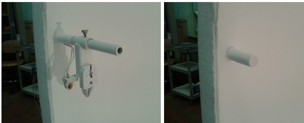
Slika 32: Odstranitev stranskih okovov cevastih sijalk za meritve točkastih virov.
