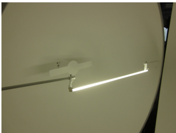
Slika 34: Montaža T5 sijalke v sferi po nadgradnji.
